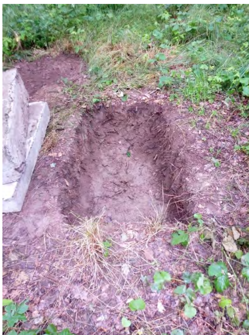
Výkop pro stavbu
